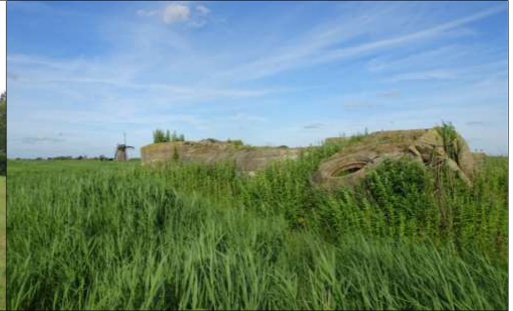
1942, Leiderdorp Duitse bunker zonder heipalen
